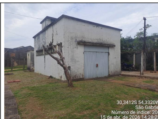
Foto 6 – Prédio Casa do Grupo Gerador/Refeitório
