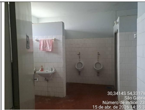
Foto 9 – Vista Interna do Vestiário/Banheiro
