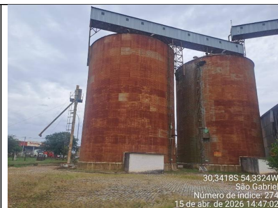
Foto 15 – Silos Metálicos e Passarela
