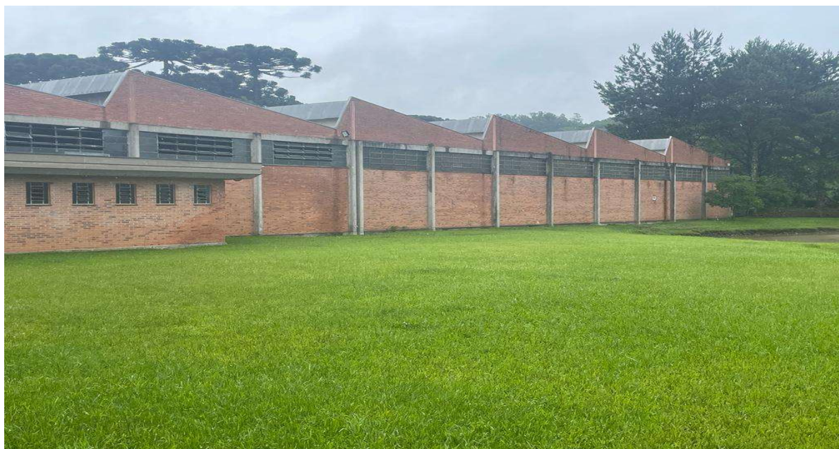
VISTA LATERAL PAVILHÃO INDUSTRIAL
